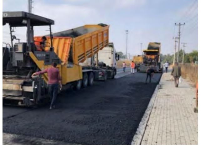
Şehir İçi Yollarda Asfalt ve Sathi Kaplama Yapım İşi
