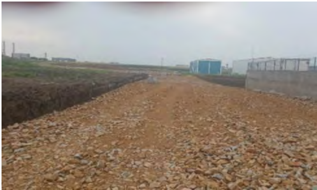
Yeni Açılacak Yollarda Hafriyat Yapılması, Dolgu Malzemenin Temini ve Serilmesi Yapım İşİ
