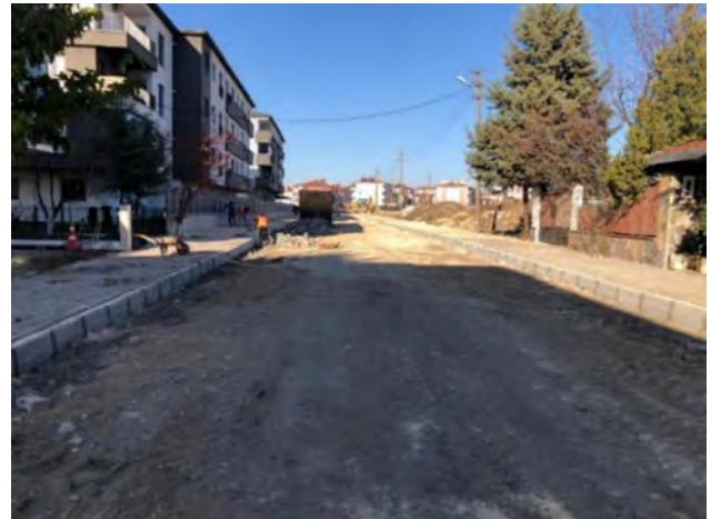
İlçemiz Muhtelif Cadde ve Sokaklarında Parke Taş Tamirat, Bakım, Onarım ve Döşeme Yapım İşİ
