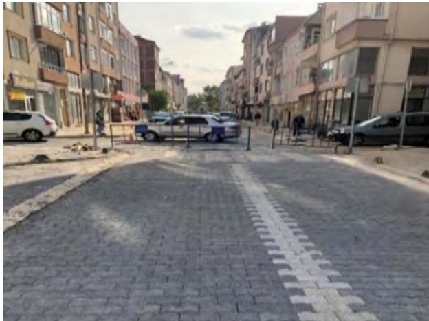
İlçemiz Emrullah Efendi Caddesi Ring Hattında Beton Parke Taş Döşenmesi Yapım İşİ
