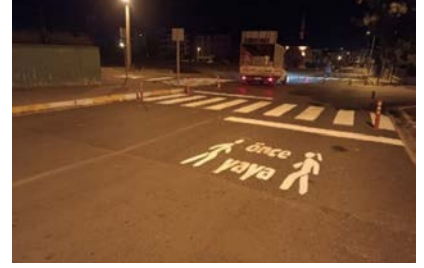
İlçemiz Sınırlar İçinde Muhtelif Cadde ve Sokaklarda Çift Kompenant ve Soğuk Yol Çizgi Boyası ile Çizgi Uygulaması ve Aşınma Asfaltı ile Hız Kesici Kasis Yapılması İşİ
