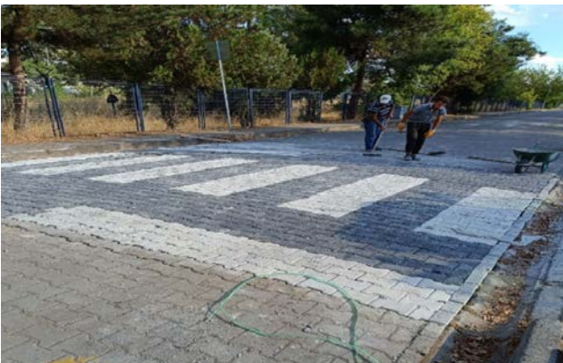
Beton Parke Taş Yollarda Tamirat Yapılması İşİ
