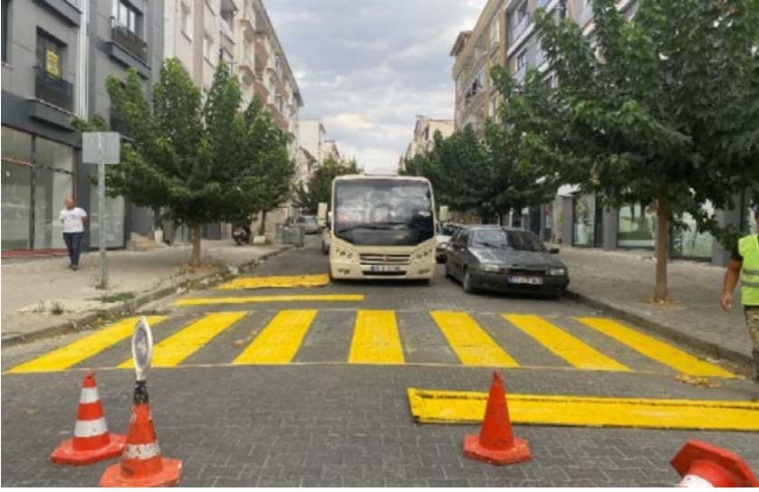
İlçemiz Sınırlar İçinde Muhtelif Cadde ve Sokaklarda Çift Kompenant ve Soğuk Yol Çizgi Boyası ile Çizgi Uygulaması ve Aşınma Asfaltı ile Hız Kesici Kasis Yapılması İşİ
