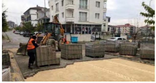
İlçemiz Muhtelif Cade ve Sokaklarında Parke Taş Tamirat, Bakım, Onarım ve Döşeme Yapım İşi
