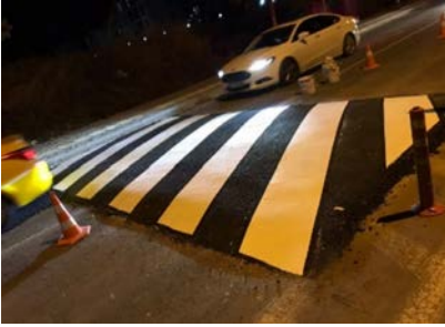
İlçemiz Sınırlar İçinde Muhtelif Cadde ve Sokaklarda Çift Kompenant ve Soğuk Yol Çizgi Boyası ile Çizgi Uygulaması ve Aşınma Asfaltı ile Hız Kesici Kasis Yapılması İşİ
